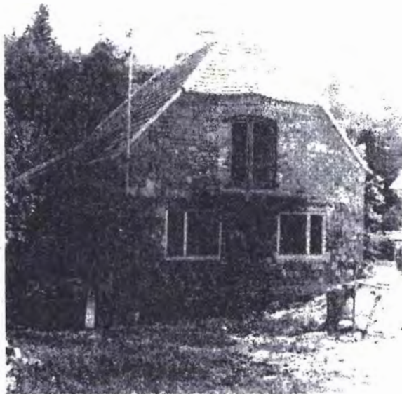
Haus Mann, Rohbau
