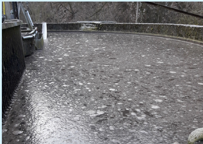
Becken der Kläranlage Rosenberg mit aufschwimmendem Fett
