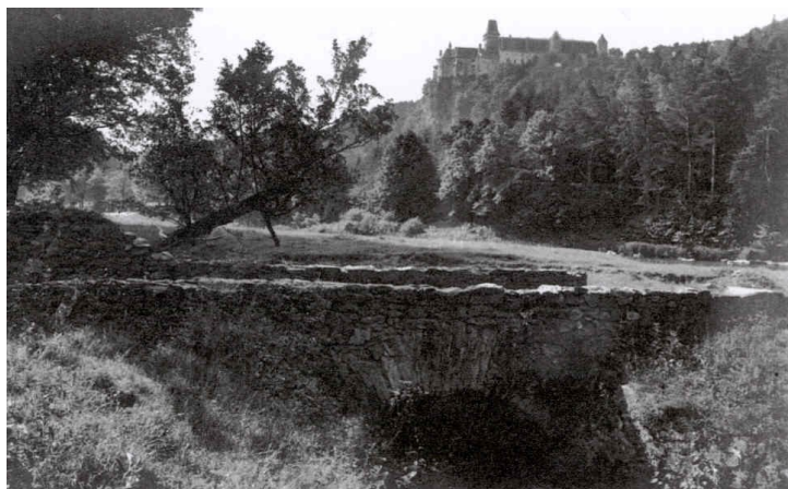
Fahrbrücke über den Mühlenschuss der Hofmühle Richtung Kampfurt. Das Gewölbe wurde 1875 abgetragen und neu aufgemauert. Schlossarchiv Rosenberg, Zentralregistratur Zl. 235/1875 vom 15.09.1897 und vom 23.09.1875 o.Z.. Die schöne Brücke wurde in den 1990er Jahren devastiert.
