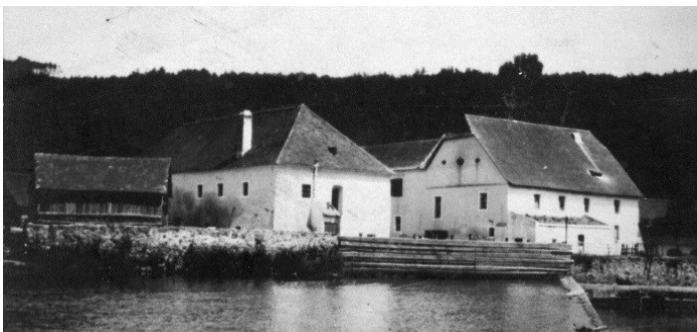
Die Hofmühle mit der im Text genannten, vom Hochwasser häufig zerstörten hölzernen „Eiswand“. Der Schuppen links war der Aufbewahrungsort für den „mobilen“ Holzrechen und die hölzernen Rinnen, die die Scheiter zur Legstätte (Scheitergarten) leiteten.
